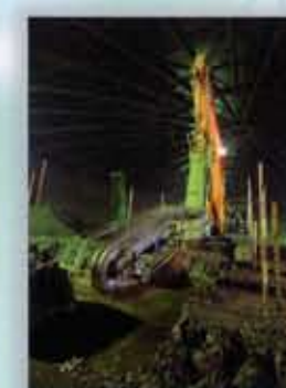
既設構造物直下の液状化対策
