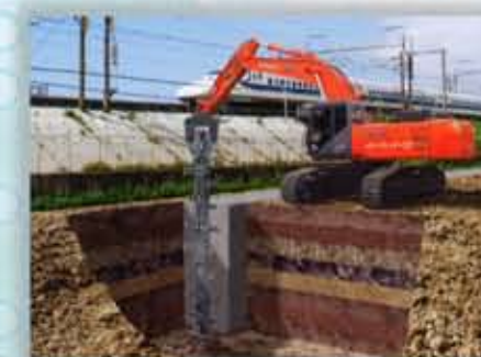
パラレル施工
