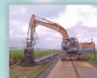
道路盛土の安定対策
