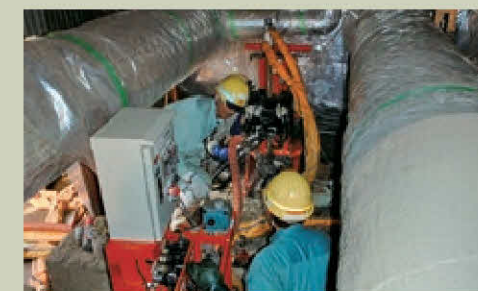
施設の配管の間から施工
