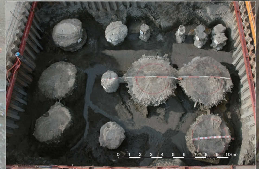
改良体出来形確認試験の状況
