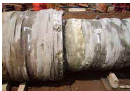
拡頭タイプSSの 掘り起こしによる確認 (拡頭継手部)
