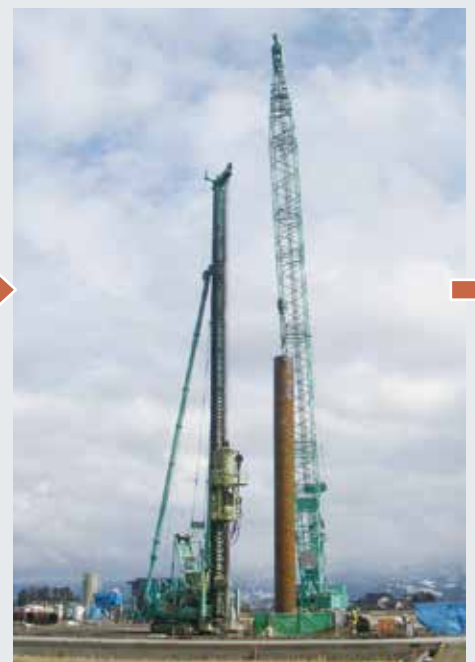
掘削攪拌（ソイルセメント柱造成）⇒鋼管建込み
