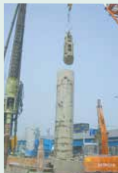
オールケーシング先行掘削
