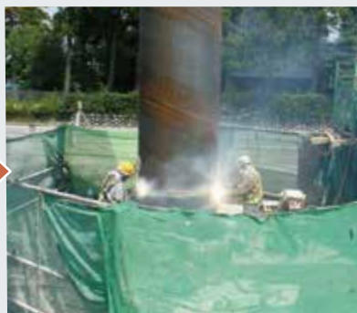
鋼管溶接(継杭の場合)
