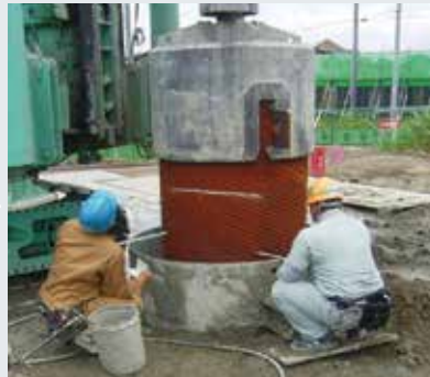
鋼管定着(ヤットコ適用)
