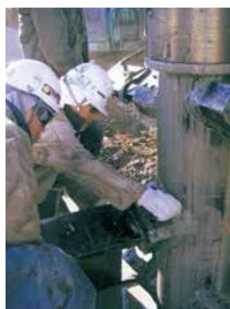
軸部攪拌翼に切替
