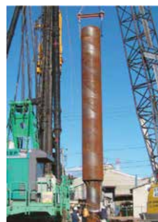
鋼管沈設
