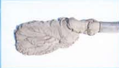
注入ポンプで加圧(低圧)すると、容易に流動化し液体の性質を示します。このような性質はエアバック特有のもので、可塑状グラウトといえます。
