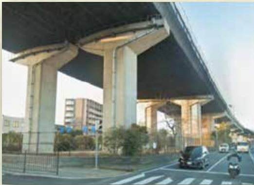
●中空充填による耐震補強
