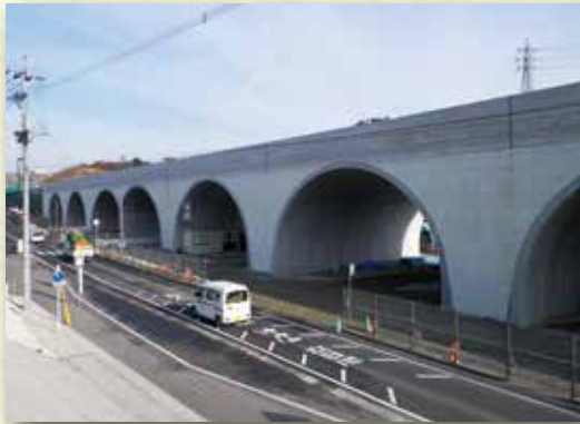
●アーチカルバート橋上軽量盛土
