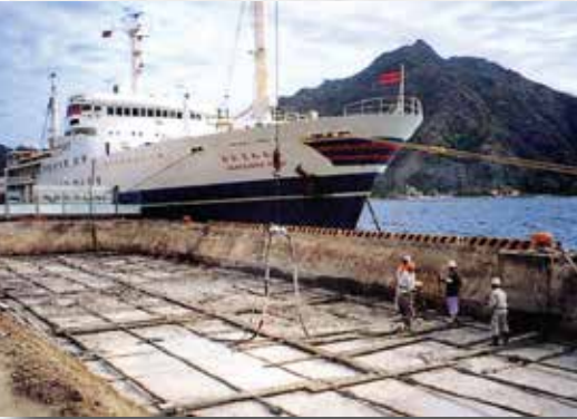
● 護岸工事の採用例(置換盛土)
