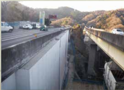
●下部空間充填による土工化
