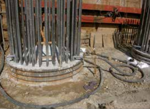
● 深礎杭裏注入
