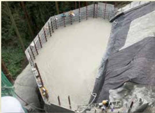
●橋脚基礎押え盛土
