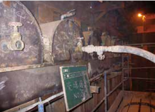
● パイプルーフ中詰工
