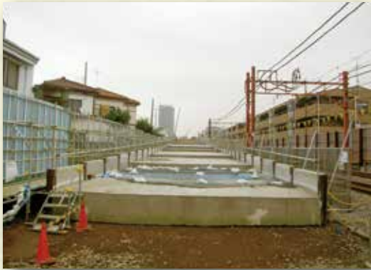
●軌道(鉄道)下路床(気泡モルタル盛土)
