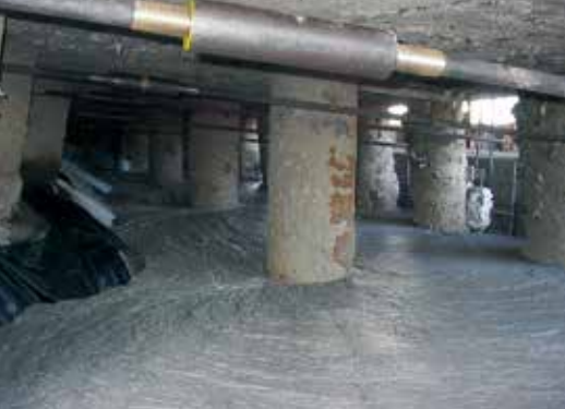
● 基礎(アバット)下軽量盛土
