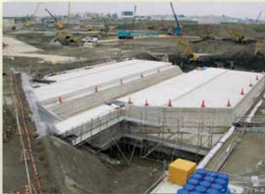
●置換盛土(地下構造物荷重軽減)
