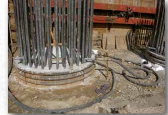
● 深礎杭裏注入
