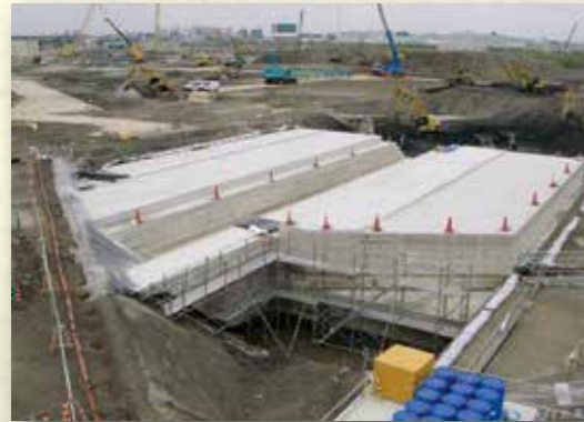
●置換盛土(地下構造物荷重軽減)
