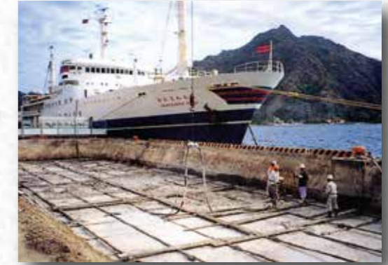
● 護岸工事の採用例(置換盛土)
