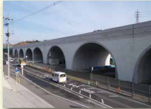
●アーチカルバート橋上軽量盛土
