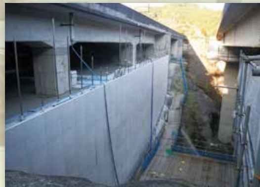
●橋梁長寿命化(土工化)
