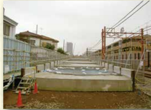
●軌道(鉄道)下路床(気泡モルタル盛土)
