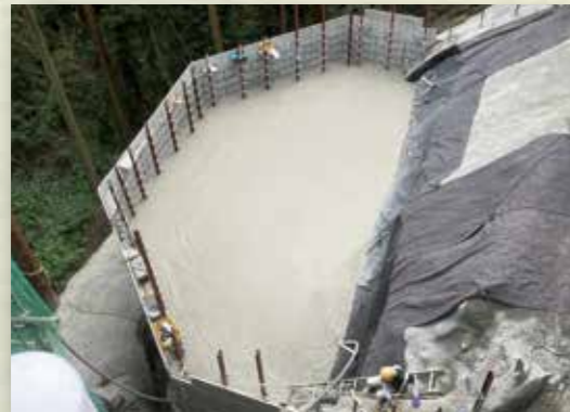
●橋脚基礎押え盛土
