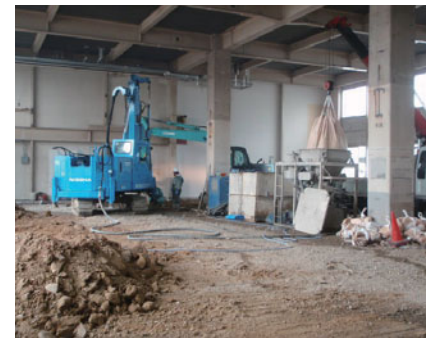
建屋内での施工
