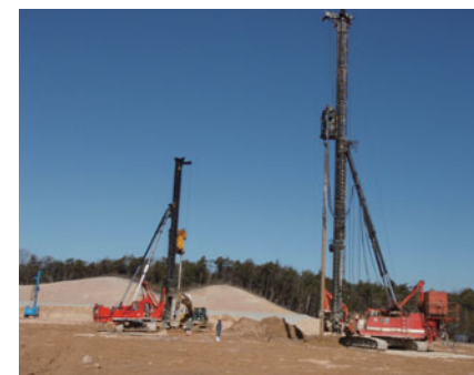
大型機での施工
