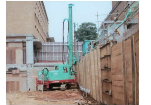
土留め壁内での施工
