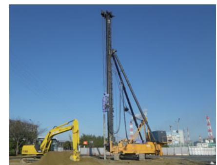
施工全景 (120t級)
