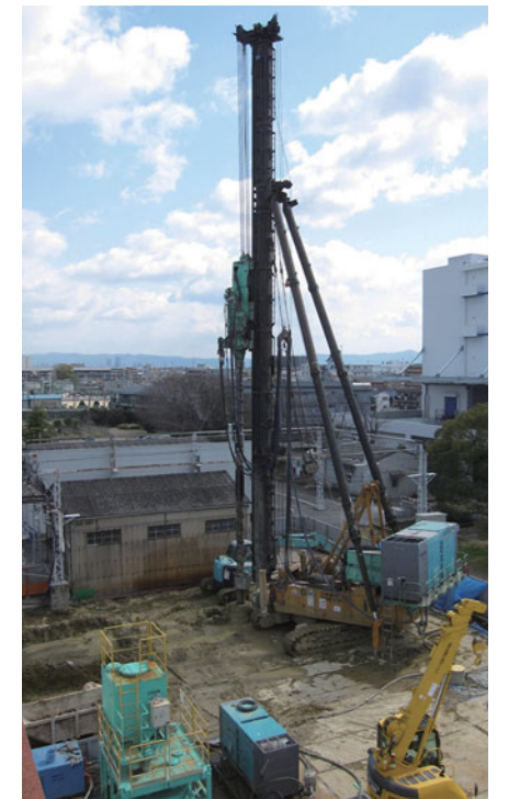
大型機での施工
