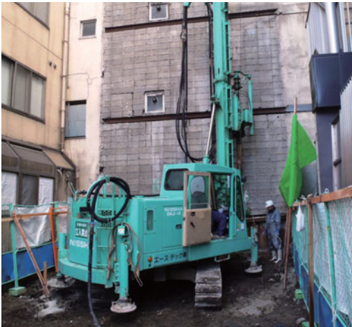
狭小地での施工状況
