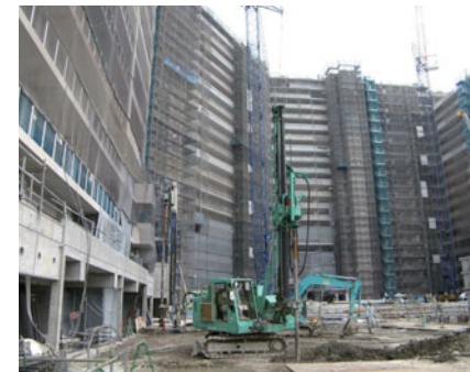
他工程との併行施工
