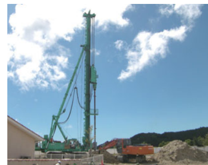
大型機での施工
