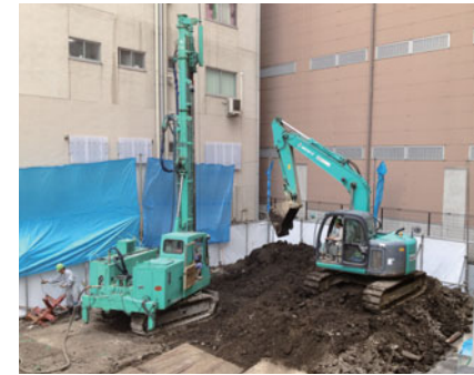
隣地近接施工
