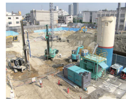
施工全景 (15t級)
