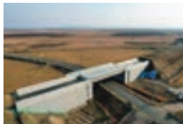
施工完了写真
