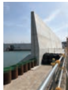
「スイムグラウト」による 港湾残置管理め戻し
