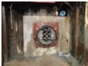
「エアスラー」による 送電線の中詰め
