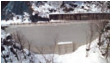
施工後（上空より）
