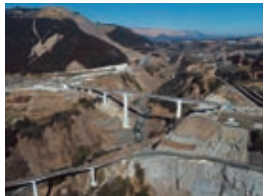
新阿蘇大橋の全景
