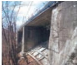
施工前（橋梁下部より）
