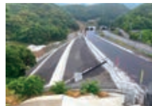
湯浅御坊道路での軽量盛土工事
