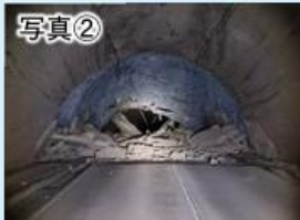
国道249号中屋トンネル崩落状況
