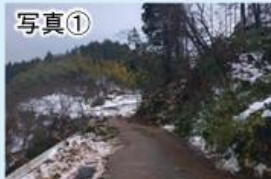
県道38号緊急復旧完了状況
