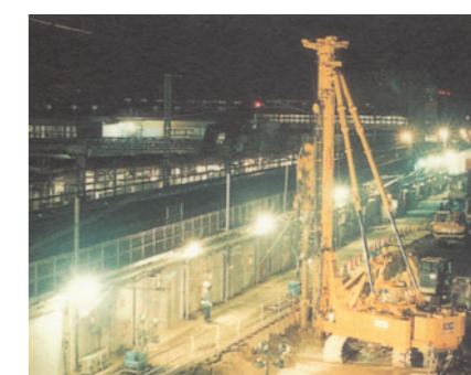
鉄道工事(夜間)
