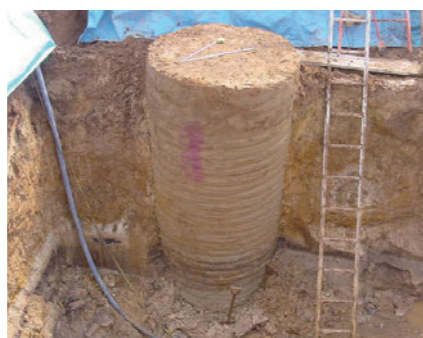
改良体掘起し
