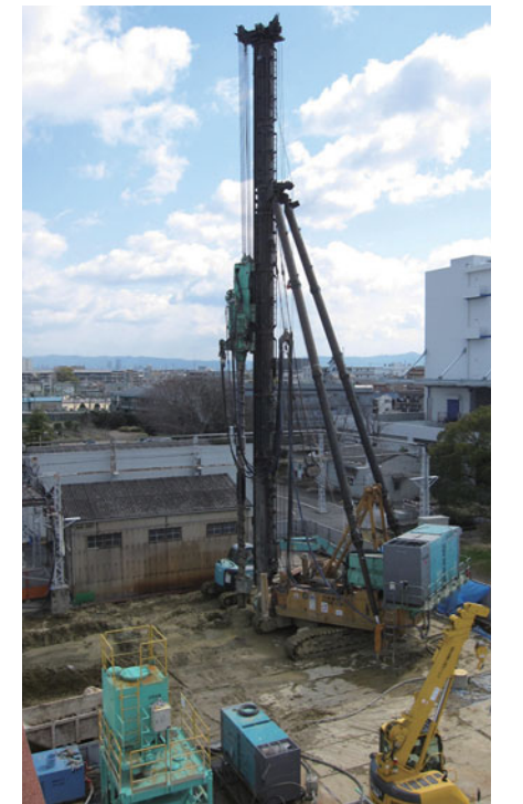
大型機での施工
