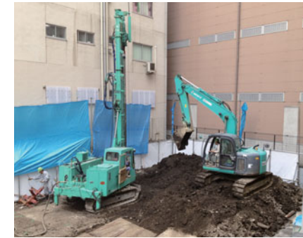
隣地近接施工
