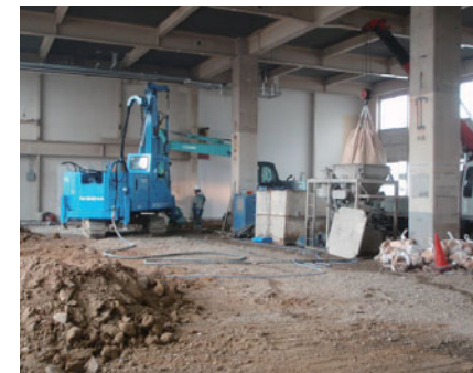
建屋内での施工
