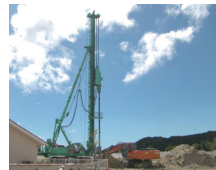
大型機での施工
