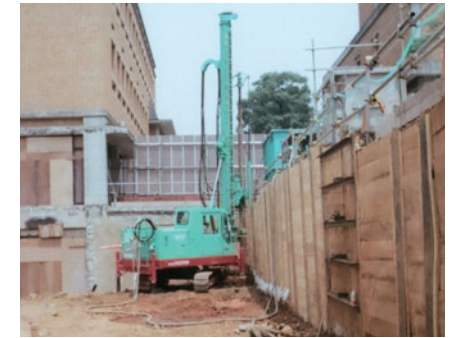
土留め壁内での施工
