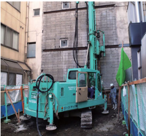
狭小地での施工状況
