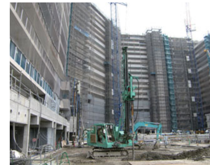
他工程との併行施工
