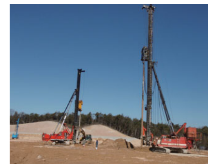
大型機での施工
